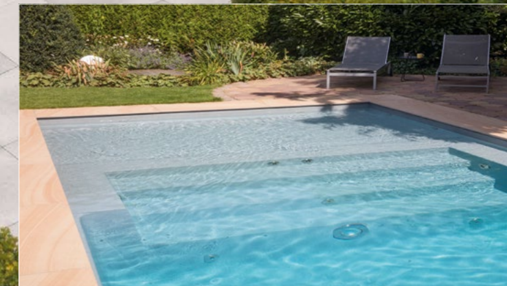
WetLounge mit der Treppenanlage Linear.
