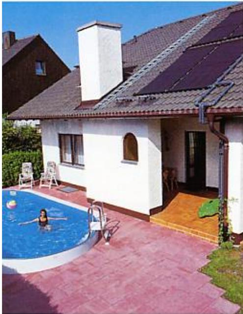
Bei einem nicht abgedeckten Freischwimmbekken muss die Kollektorfläche etwa der Wasseroberfläche des Beckens entsprechen (gültig für Mitteleuropa). Um ein zu starkes Abkühlen des erwärmten Wassers zu verhindern, sollte man das Becken mit einer Abdeckung versehen. Dadurch reduziert sich die notwendige Kollektorfläche auf 60% der Wasserfläche.
